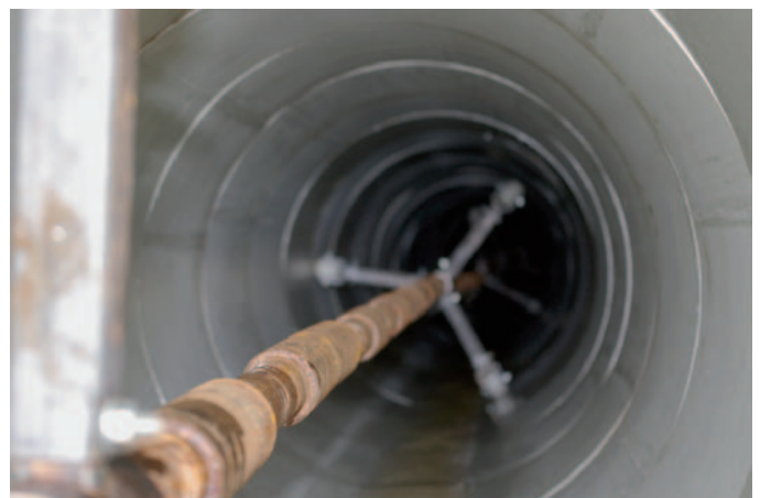
Bild 5: Zentriertes Zuggestänge während des Einziehvorgangs
