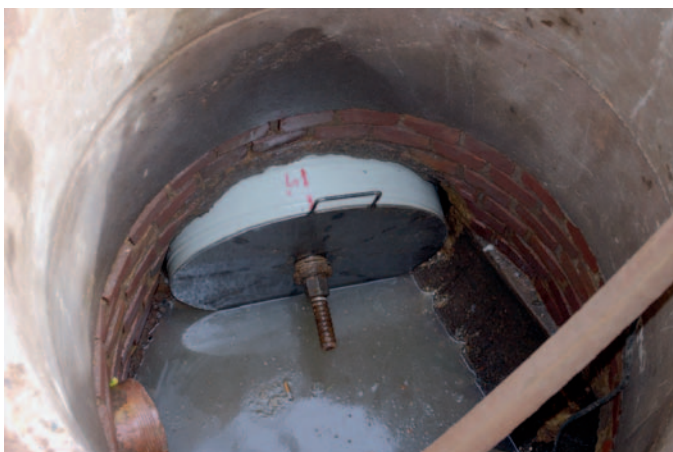
Bild 4: Rohrmodul während des Einziehvorgangs im Startschacht
