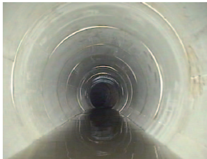
Bild 7: Mit PP-Kurzrohr-Modulen sanierter Kanal
