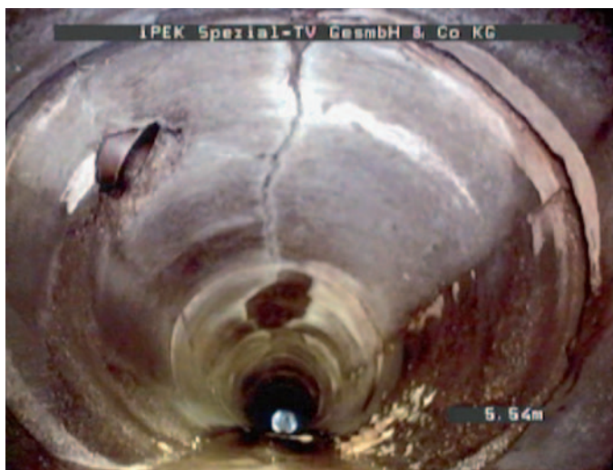
Bild 6: Altkanal vor der Sanierung
