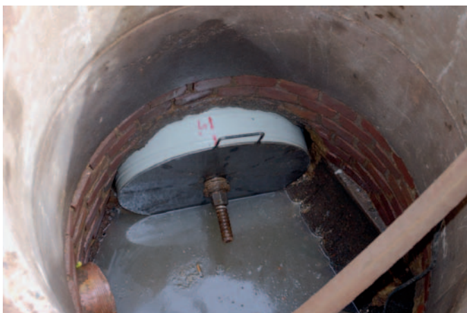
Bild 4: Rohrmodul während des Einziehvorgangs im Startschacht
