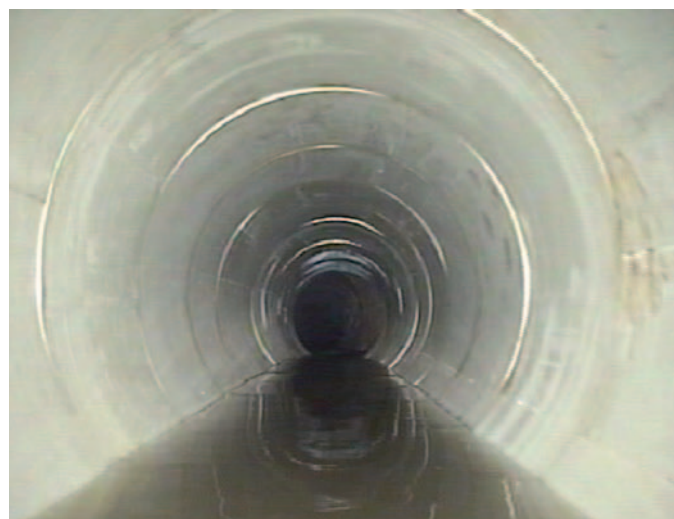
Bild 7: Mit PP-Kurzrohr-Modulen sanierter Kanal
