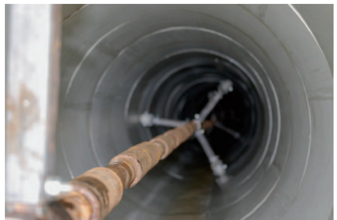
Bild 5: Zentriertes Zuggestänge während des Einziehvorgangs
