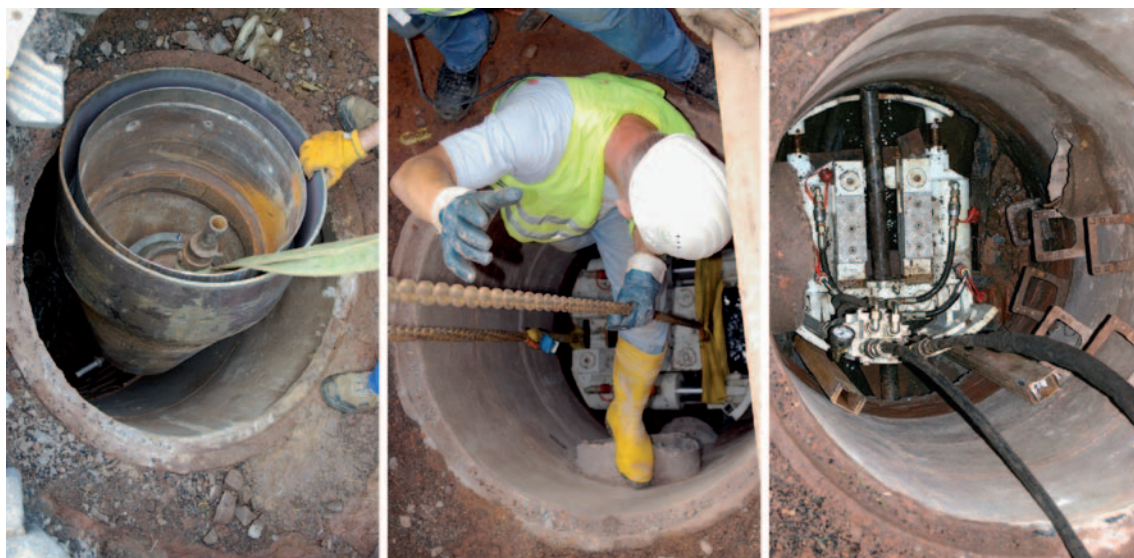
Bild 2: Einbringen des Zugkopfs in den Startschacht (links), Einbringen der Zugmaschine in den Zielschacht (Mitte) und Zugmaschine während des Einziehvorgangs (rechts)
