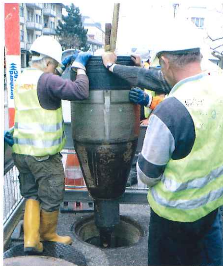
pipe-Verfahren: Einführen der Gerätschaften durch einen normalen Schachteinstieg ohne Baugrube.
