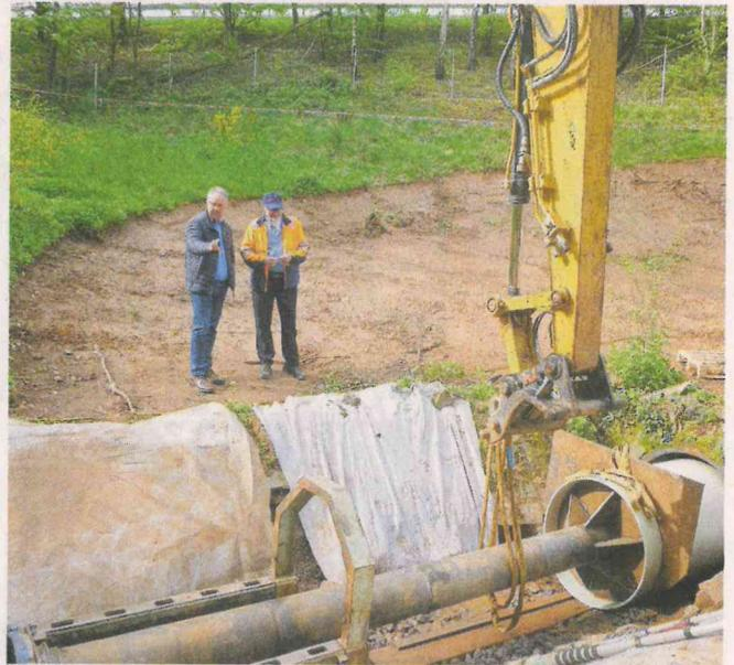
Dieser Tage wurde mit dem Bau von 2 weiteren Kleinregenrückhalten (KRH 2 und KRH 6) östlich der BAB 8 begonnen. Mit diesen beiden Rückhalten wird ein Rückhaltevolumen von 7.600 m<sup>3</sup> geschaffen.
