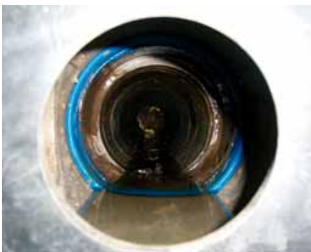
Bohrkanal mit Abdichtung hinter der Schachtwand.
