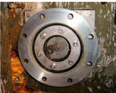
Vorwandplatte mit Dichtung.
