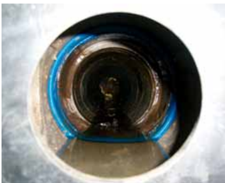
Bohrkanal mit Abdichtung hinter der Schachtwand.
