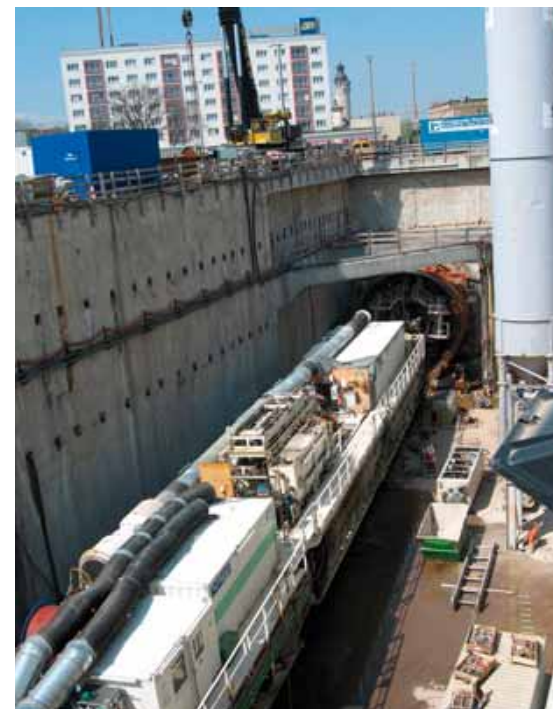
Vorbereitung auf die zweite Röhre: Die Schildbohrmaschine, hergestellt von der Firma Herrenknecht, hat einen Durchmesser von neun und eine Länge einschließlich der Nachläufer von 65 Metern.
