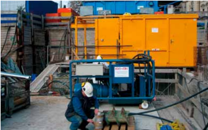
Baustelleneinrichtung: Der Container ist über der Schachttöffnung aufgestellt.
