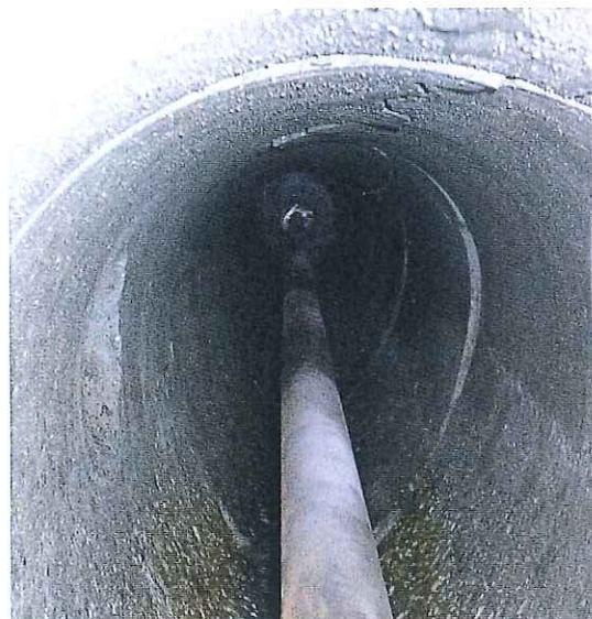
Zugkopf mit Gestänge im alten Eiprofil 500/750.
