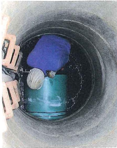
Rohrmontage Da 630 im DN 1000 Schacht.
