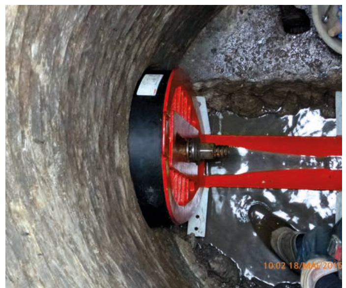
Druckplatte auf dem Rohr im Startschacht.
