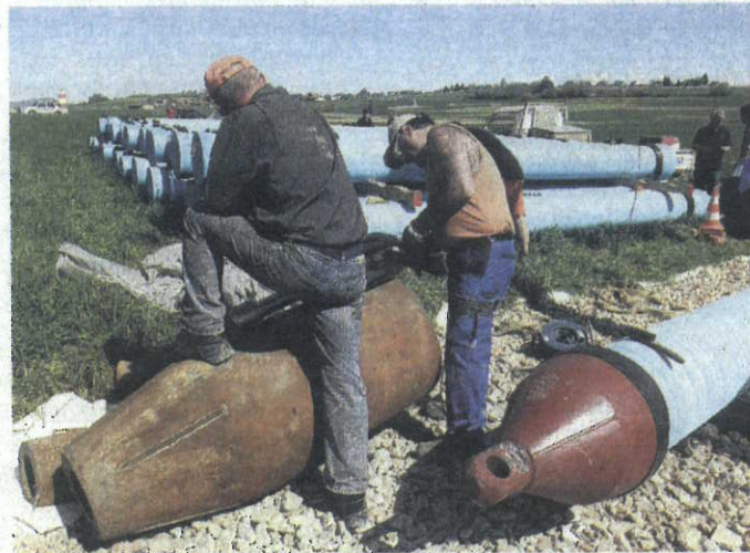
Der Berstkopf (vorne links) drückt die bestehende Wasserleitung auseinander.
