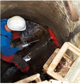
Kontrolle des Rohres vor dem Einschub.
