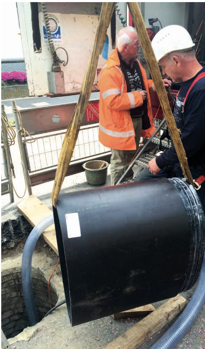
Einlass des Rohres in den Startschacht.
